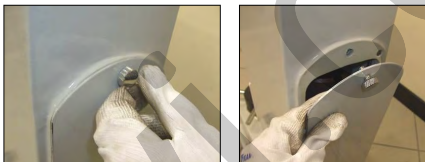
Figura 6 - Accesso al vano pesi.
